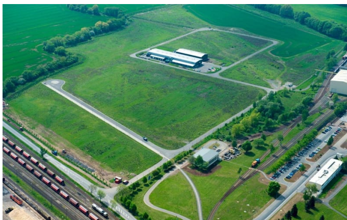
Rottleberode - Industriegebiet An der Krummschlacht 2.jpg
