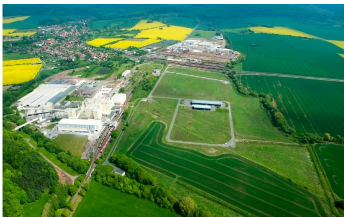
Rottleberode - Industriegebiet An der Krummschlacht.jpg
